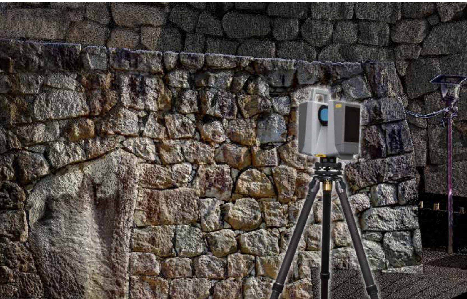
Trimble SX12で計測した高密度の石垣
